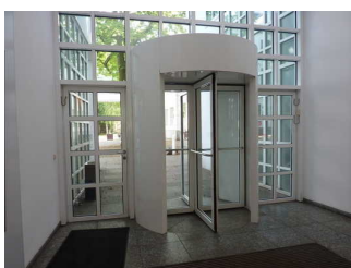
Türen im Eingangsbereich
