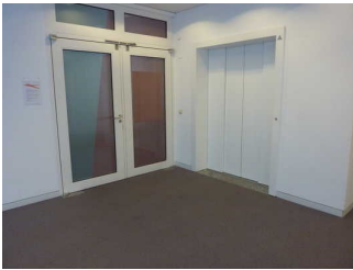
Flur vom Aufzug zur Werkstatt
