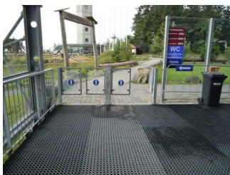
Weg von Bergstation zum Hochheideturm
