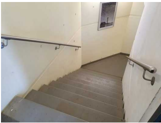
Treppe zur Aussichtsplattform
