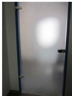
Tür zwischen Sammelumkleidekabine und Schwimmbereich
