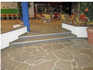
Treppe im Schwimmbad-Innenbereich
