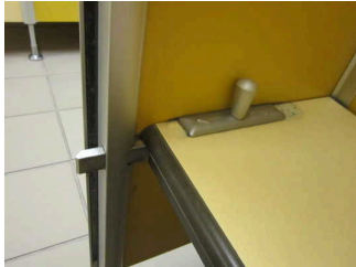
Türverschlussvorrichtung in Einzelumkleidekabine
