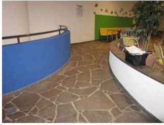
Rampe im Schwimmbad- Innenbereich
