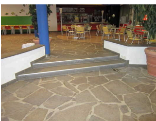
Treppe im Schwimmbad-Innenbereich
