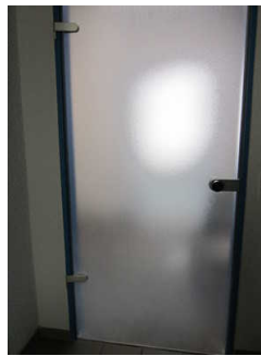
Tür zwischen Sammelumkleidekabine und Schwimmbereich
