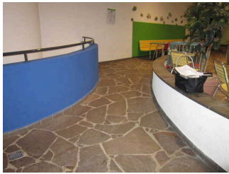
Rampe im Schwimmbad- Innenbereich
