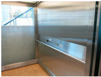
Aufzug zwischen Foyer 1.07 und Foyer 3.12
