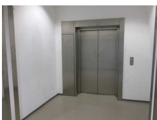
Aufzug zur Dachterrasse
