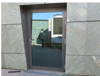
Tür zur Dachterrasse
