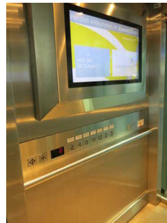
Hauptaufzüge vom atrium zu den verschiedenen Ebenen
