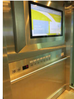
Hauptaufzüge vom atrium zu den verschiedenen Ebenen
