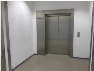
Aufzug zur Dachterrasse
