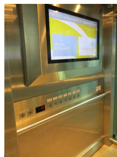
Hauptaufzüge vom atrium zu den verschiedenen Ebenen
