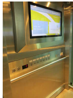
Hauptaufzüge vom atrium zu den verschiedenen Ebenen
