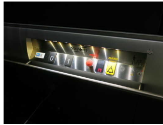
Aufzug zwischen Raum ferrum und Foyer 3.11
