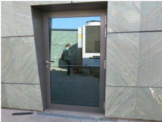
Tür zur Dachterrasse
