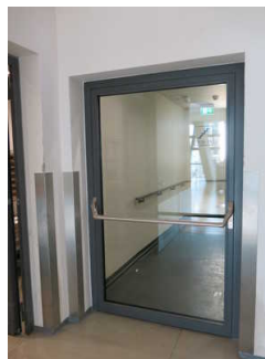
Türen zum Treppenhaus von Foyer 3.11 zur Dachterrasse
