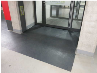
Rampe zur Tür der Tiefgarage (Ausgang zu Aufzügen)
