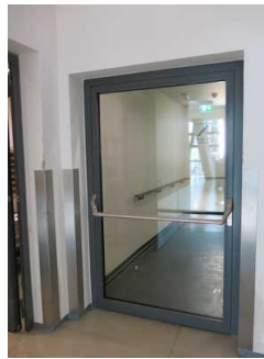
Türen zum Treppenhaus von Foyer 3.11 zur Dachterrasse
