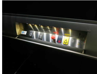
Aufzug zwischen Raum ferrum und Foyer 3.11
