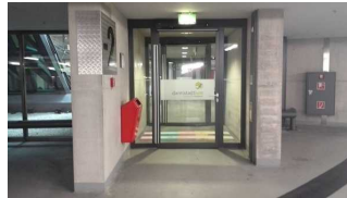
Rampe zur Tür der Tiefgarage (Ausgang zu Aufzügen)
