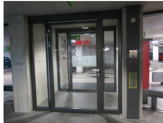
Tür von der Tiefgarage zu den Aufzügen
