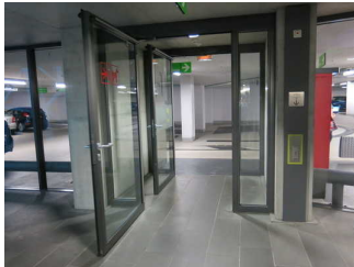
Tür von der Tiefgarage zu den Aufzügen
