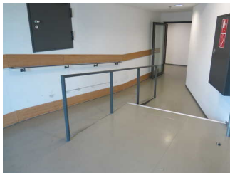
Rampe zur Dachterrasse
