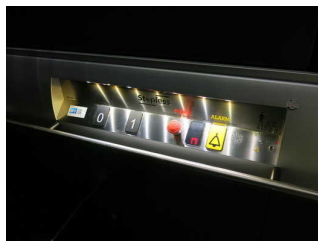
Aufzug zwischen Raum ferrum und Foyer 3.11
