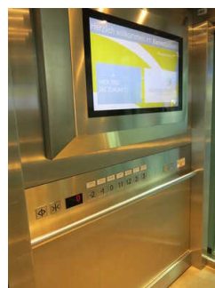
Hauptaufzüge vom atrium zu den verschiedenen Ebenen
