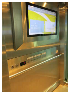
Hauptaufzüge vom atrium zu den verschiedenen Ebenen
