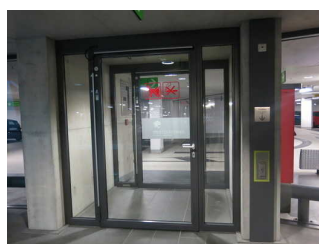
Tür von der Tiefgarage zu den Aufzügen
