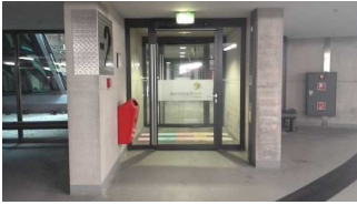
Tür von der Tiefgarage zu den Aufzügen
