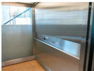
Aufzug zwischen Foyer 1.07 und Foyer 3.12
