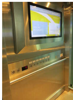
Hauptaufzüge vom atrium zu den verschiedenen Ebenen
