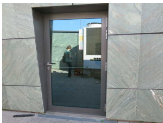
Tür zur Dachterrasse
