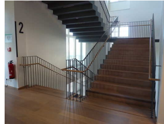
Treppe vom EG zum 1. - 3. OG
