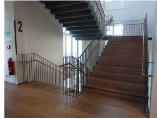
Treppe vom EG zum 1. - 3. OG
