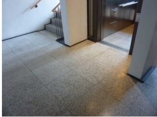
Flur von Treppe / Aufzug zur Tür der Bibliothek
