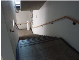
Treppe zum WC und zur Gemäldegalerie
