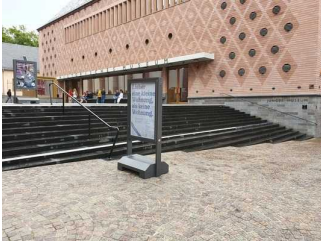
Treppe vor dem Haupteingang
