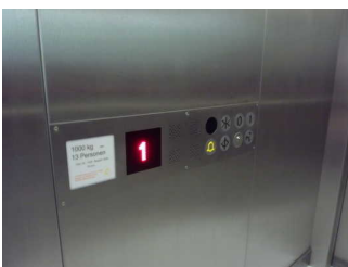
Bedientableau im Aufzug
