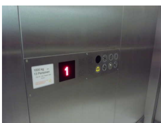
Bedientableau im Aufzug
