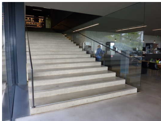
Treppe vom EG ins OG
