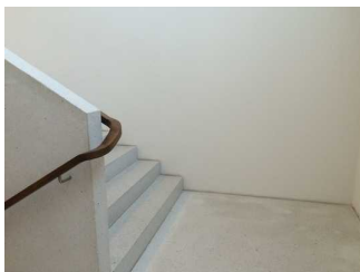
Treppe vom Erdgeschoss zum Untergeschoss
