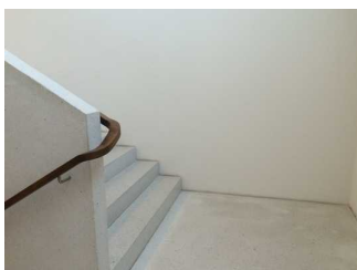
Treppe vom Erdgeschoss zum Untergeschoss
