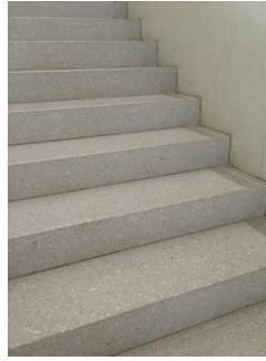
Treppe vom Erdgeschoss zum Obergeschoss
