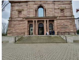
Außentreppe am Eingang
