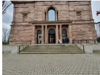
Außentreppe am Eingang
