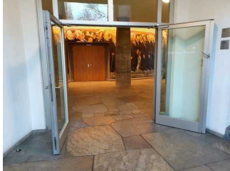
Tür zwischen Hintereingang / Treppe zum Plenarsaal zur Wandelhalle
