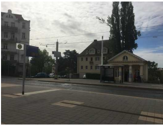
Bahnsteig Kongress Palais/Stadthalle
