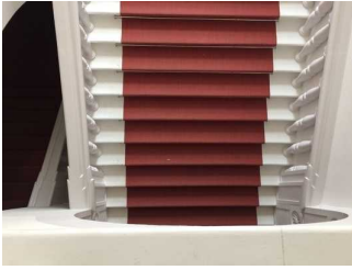
Treppe untere Saalebene zur oberen Saalebene
