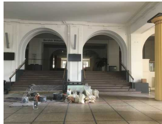
Treppe vom Vestibül zur unteren Saalebene
