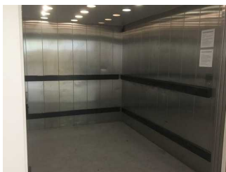
Aufzug vom Vestibül in die Saalebenen
