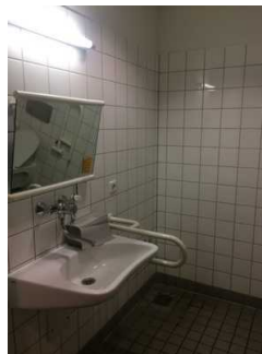
Öffentliches WC im Aschrottfoyer
