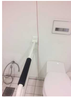
Öffentliches WC im Kolonnadenfoyer in der unteren Saalebene
