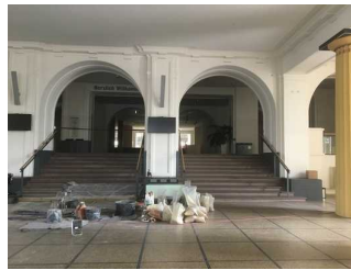
Treppe vom Vestibül zur unteren Saalebene
