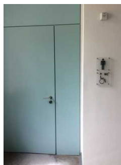
Tür vom Treppenhaus in der unteren Saalebene zum Öffentlichen WC
