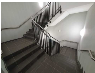
Treppe zu allen Stockwerken
