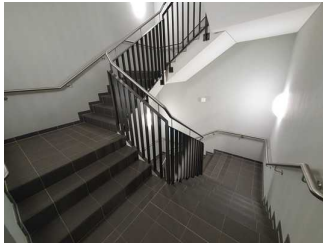
Treppe zu allen Stockwerken
